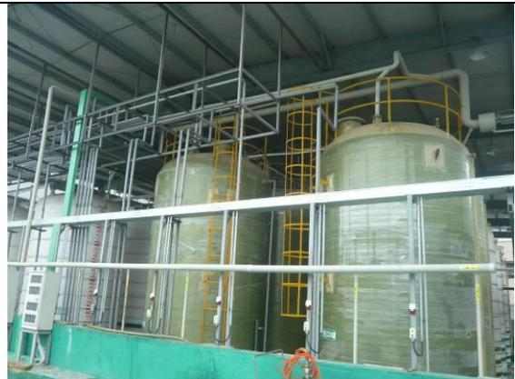
储罐区废气收集
